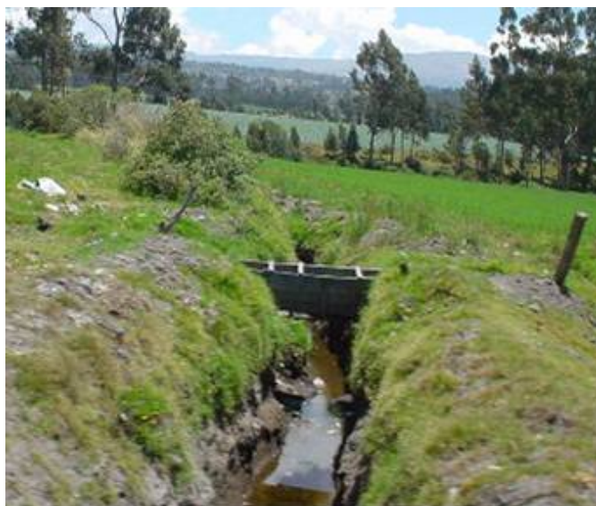
Figura 8. Infraestructuras de conducción hídrica.
